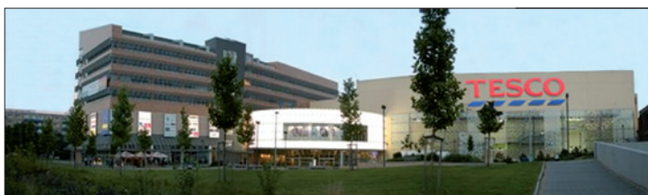
Obr. 1. Tesco Praha – regulace osvětlení podzemních garáží v závislosti na provozu v nákupním středisku Eden
